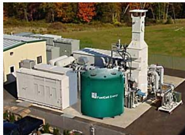
Elektrownia o mocy 1 MW na bazie MCFC, firma Fuel Cell Energy.
