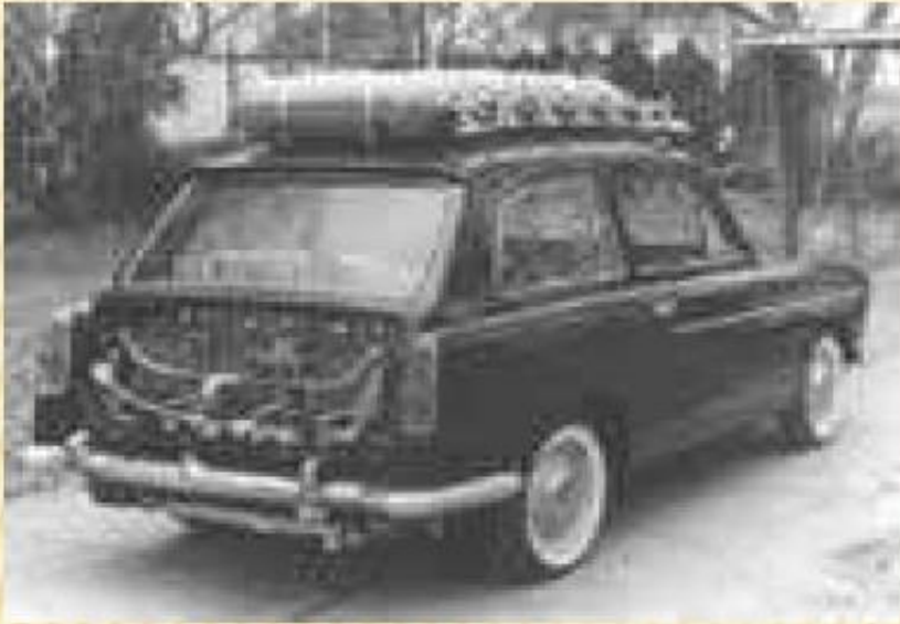
Hybrydowy samochód z ogniwem paliwowym firmy Kordesch, 1970.
